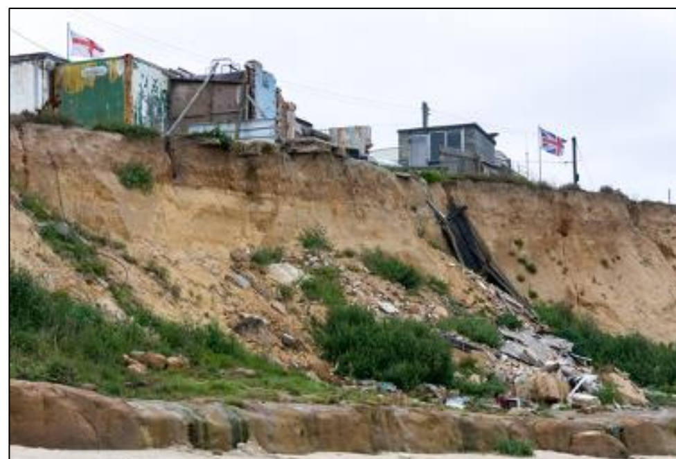
Erosão das encostas
