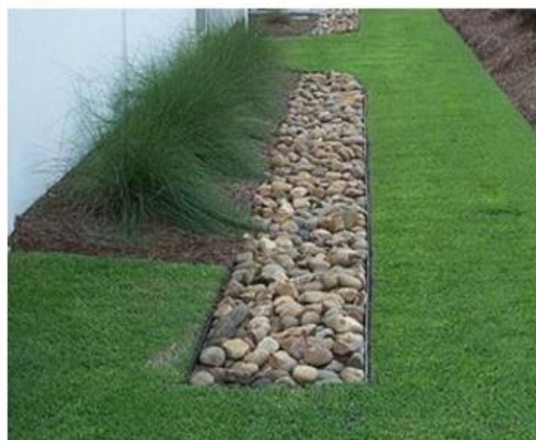
(a) Trincheira de infiltração
