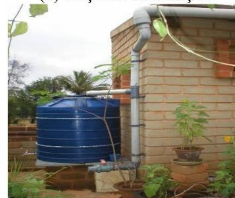
(f) Reservatório de retenção
