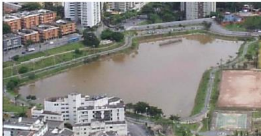
Barragem Sta. Lúcia
